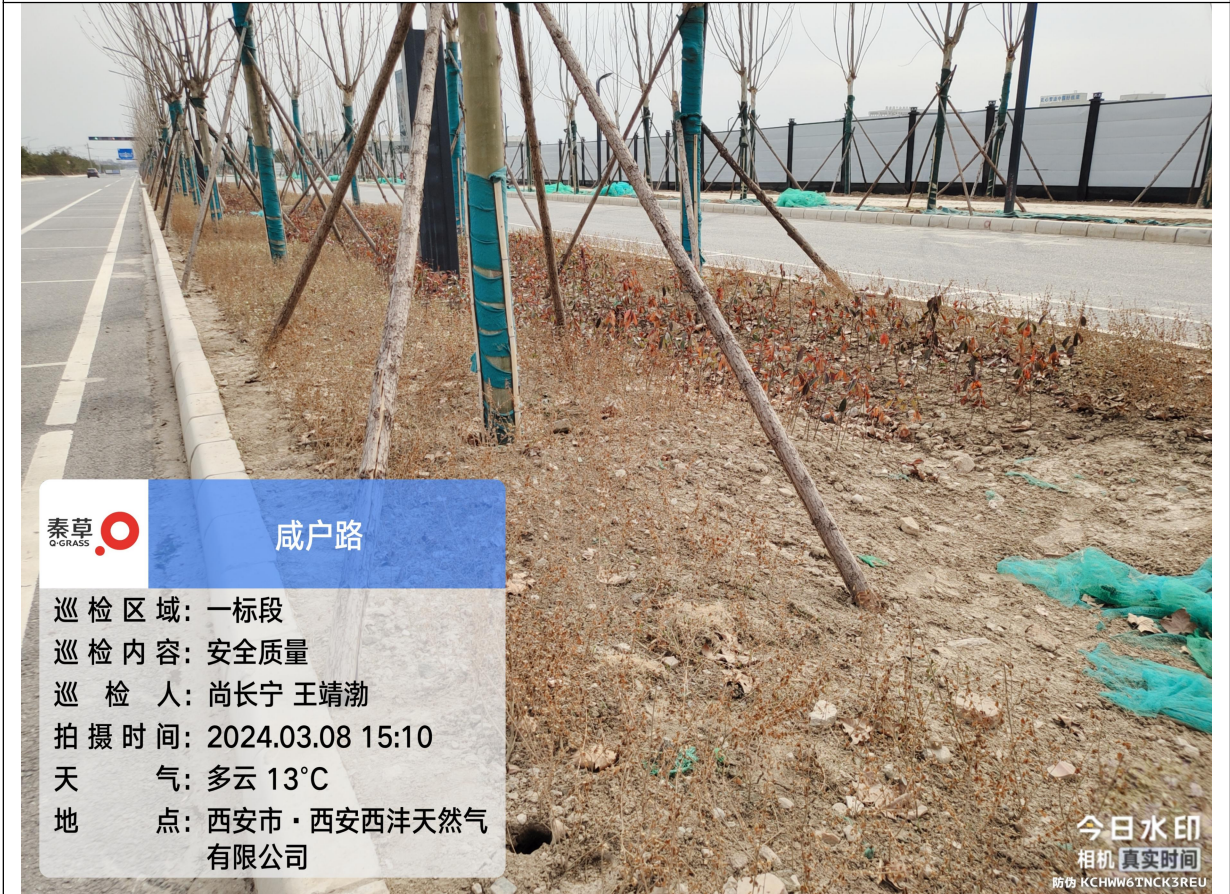
①侧分带灌木群（小叶女贞篱）已干枯缺水；
