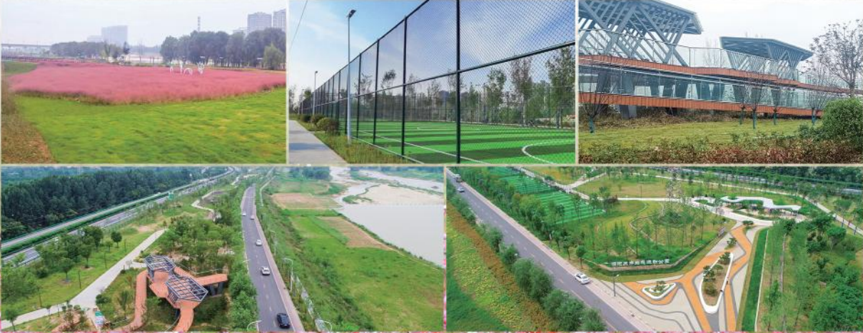
灞河左岸堤外环境综合治理
